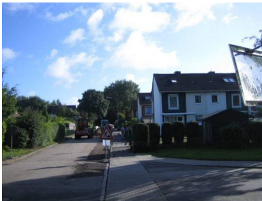
Abb.: Reihenhäuser an der Hansestraße
