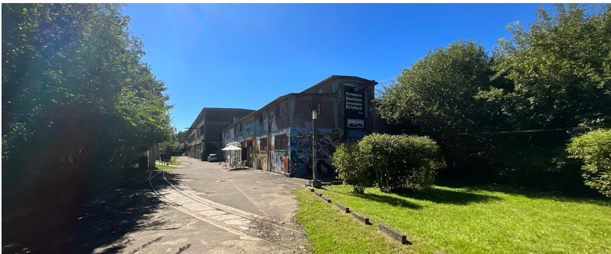
Abbildung 1: Blick auf die durch den planet-alsen e.V. gepachteten Gebäude im südwestl. Geltungsbereich (Quelle: A+S, 2023)
