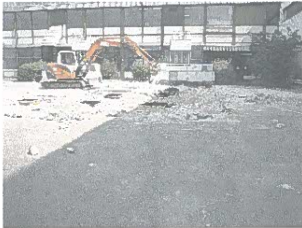
Foto 3: Für die Erstellung der Bodenmischprobe Mp1 werden ca. 10 Einzelproben (Tiefe 0-0,6m) entnommen und zur Mischprobe Mp1 zusammengefügt.
