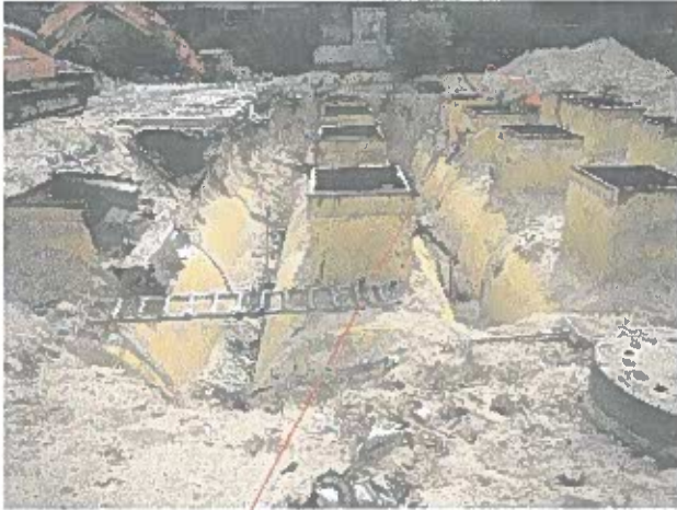
Foto 9-11: Blick auf die freigelegten Tanks 5-8. Auffällige Blauverfärbung im Bereich des Tanks 8. Entnahme der Einzelprobe Tank 8 - Schacht.
