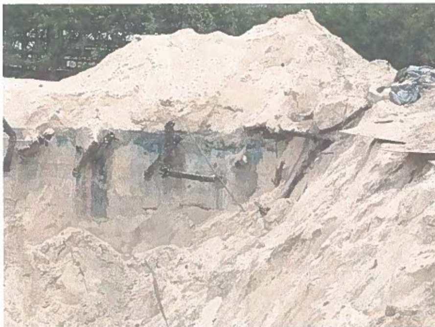
Foto 14: Teilverfüllung zur Grubenstabilisierung vor Ausbau von Tank 2 (Aufnahmedatum: 28.07,2014)
