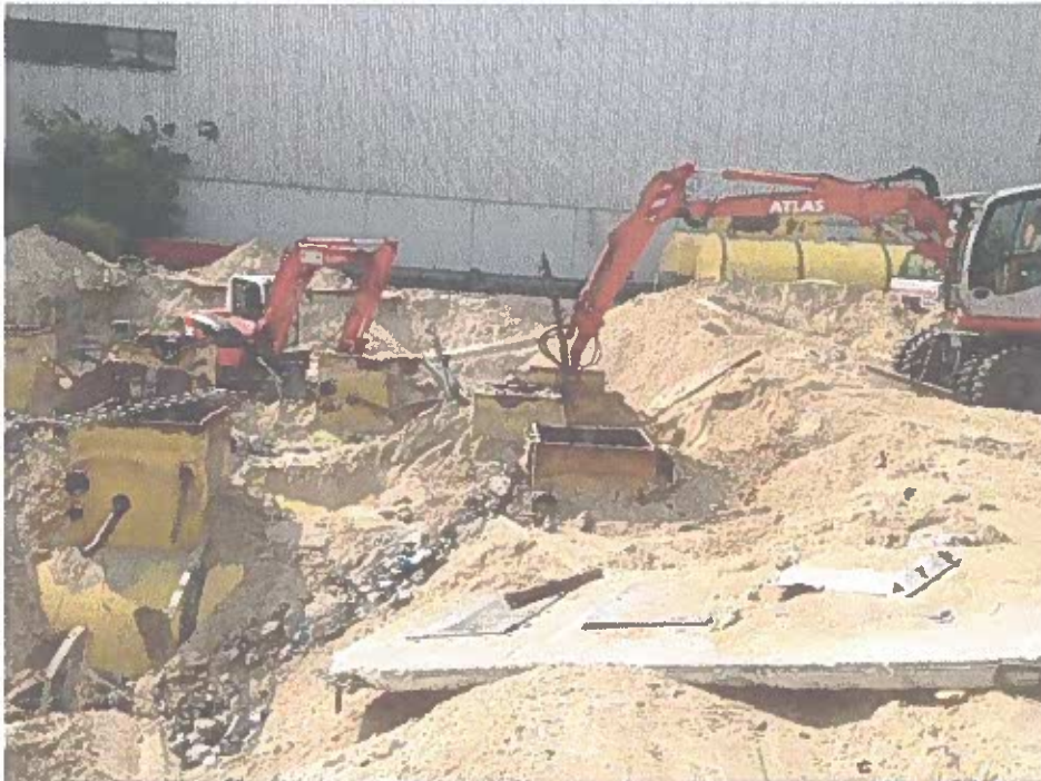
Foto 18: Freilegung der Tanks 3,4,5 (Aufnahmedatum 30.07.2014)
