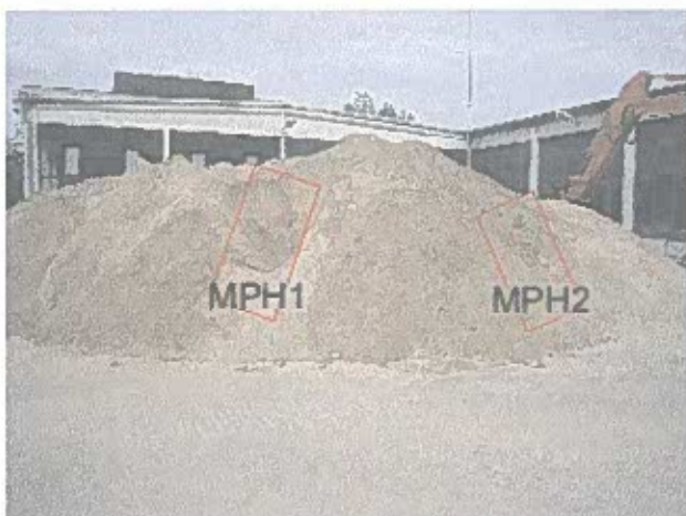
Foto 13: Ansicht Haufwerk Boden- aushub mit vorderseitigen Beprobungsbereichen.
