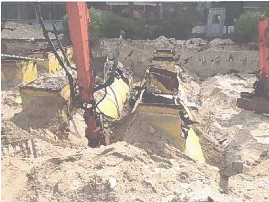
Foto 19: Freilegung der Tanks 3,4,5 (Aufnahmedatum 30.07.2014)
