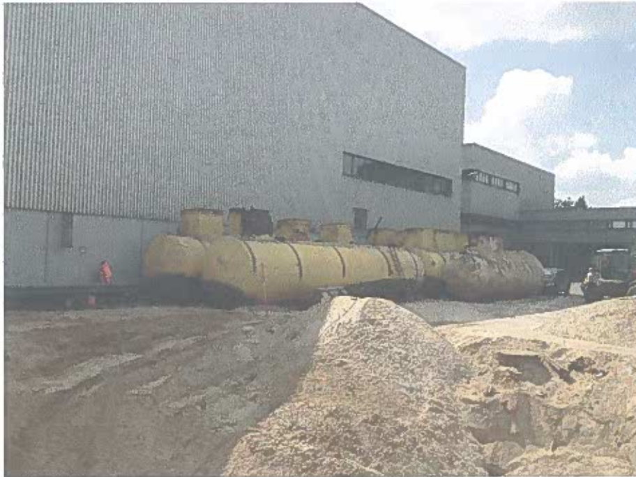
Foto 16. Ausgebaute Tanks bereit zum Abtransport (Aufnahmedatum 28.07.2014)
